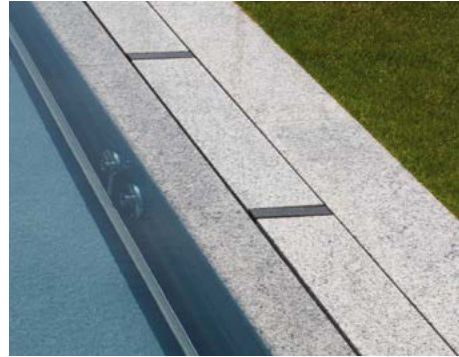
GOUTTIÈRE DE DEBORDEMENT RECOUVERTE
