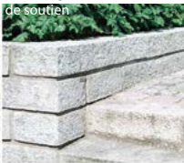
Blocs de granit comme mur de soutien
